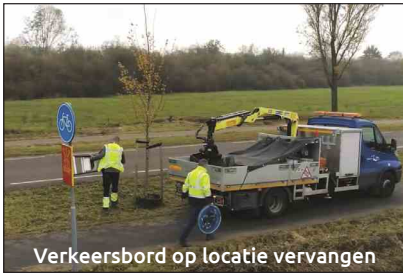
Verkeersbord op locatie vervangen
